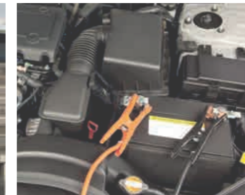
Baterías de coches eléctricos (magnitud superior a 15 kWh)
