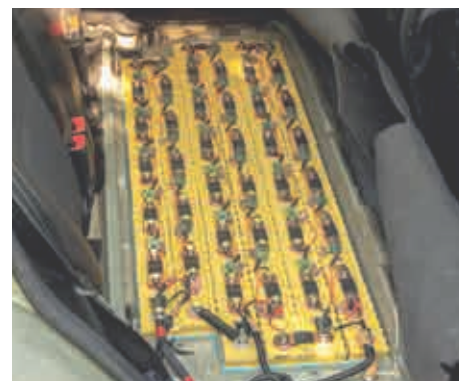
Zones de stockage de batteries importantes et/ou non surveillées
